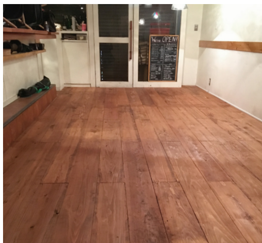
大引(米松KD 90角)に直接施工
